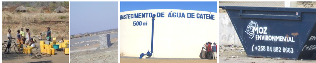
Figura 54 – Abastecimento através de Furo; Latrina Melhorada; Recolha de RSU
